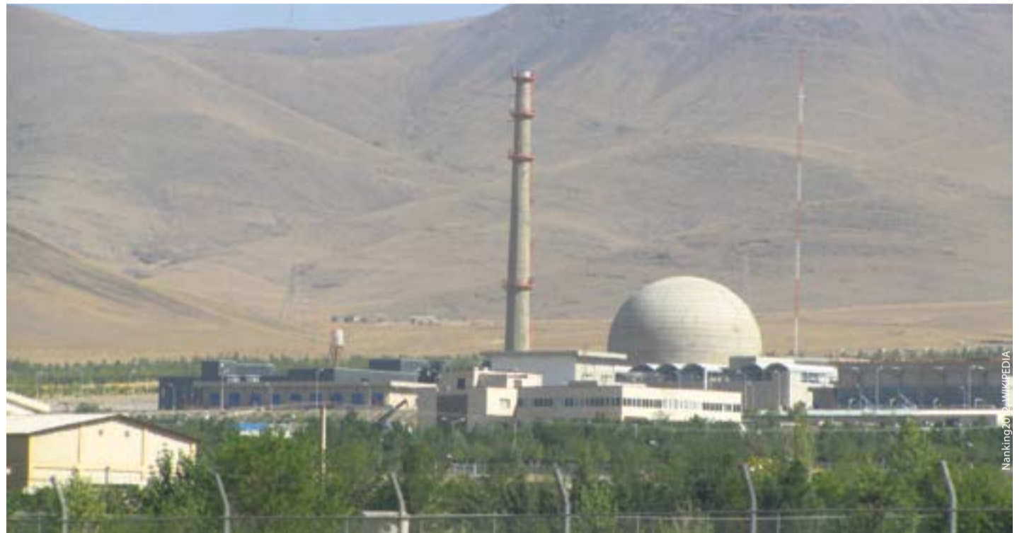
Reaktor IR-40, Teil der kerntechnischen Anlage in Arak
